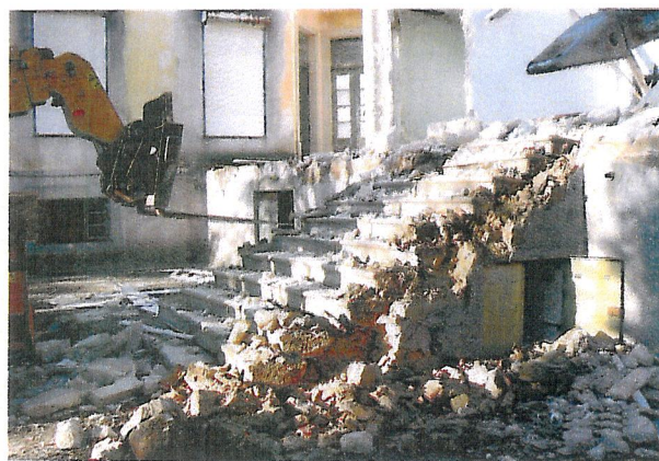
Obras de demolição do Antigo Hospital
